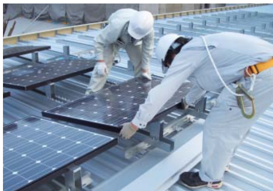
● 太陽光発電システム取付風景
