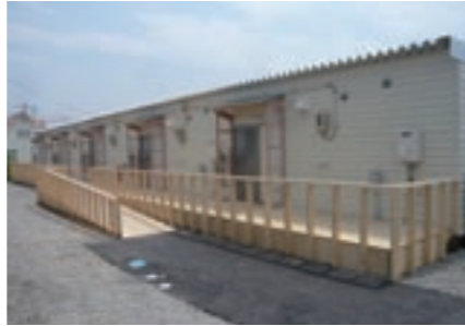
仮設住宅の建設
